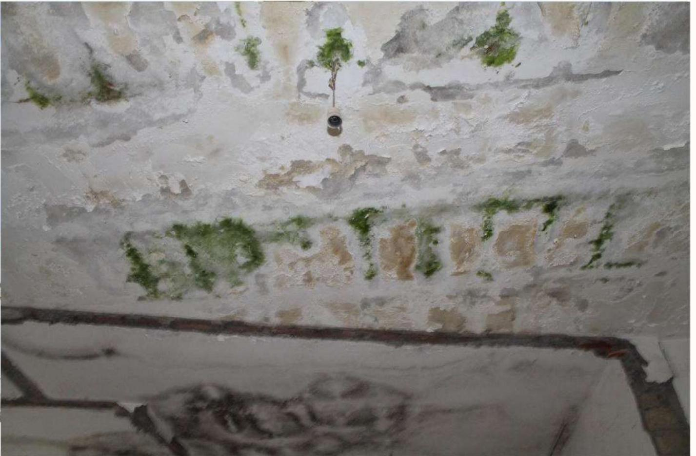
*Solaio soffitto danneggiato per infiltrazioni d'acqua*
